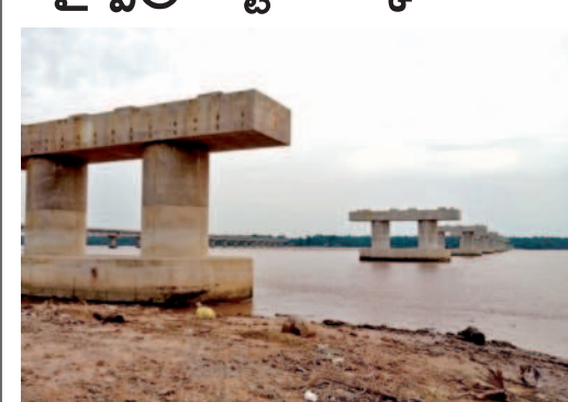
నిర్మాణం మధ్యలో నిలిచిపోయిన రైల్వే బ్రిడ్జి వసులు
